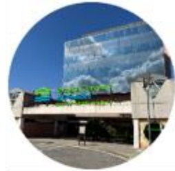
Hospital Comarcal de l'Alt Penedès
